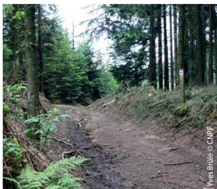
**La piste forestière**, de 3 à 4 m de large, en terrain naturel, permet l'accès aux engins de débardage (débardeur, porteur) pour amener les bois vers les places de dépôts.
