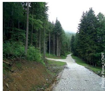
**La route forestière**, avec une bande de roulement de 3,5 m au minimum, empierrée et compactée, permet la circulation des grumiers en tout temps pour évacuer les bois.
