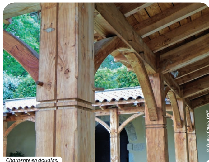
Charpente en douglas.
